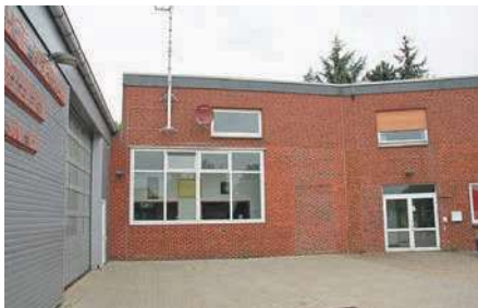
Im Bützflether Gerätehaus herrscht Sanierungsstau
