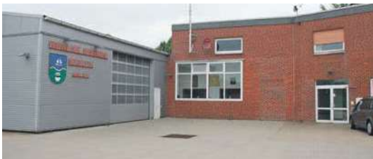
Fahrzeughalle (li.) und Haupthaus
