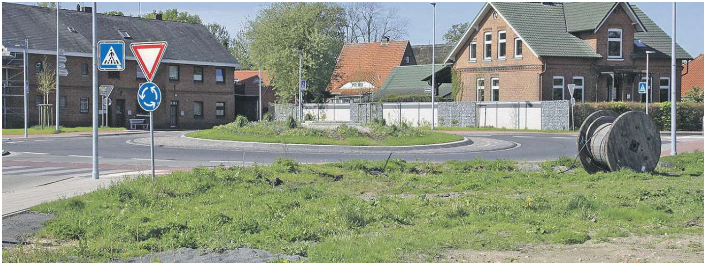
Auf diesem Baugrundstück am Nord-Kreisel (hi.) entstehen 18 barrierefreie Mietwohnungen für Senioren Fotos: tp
