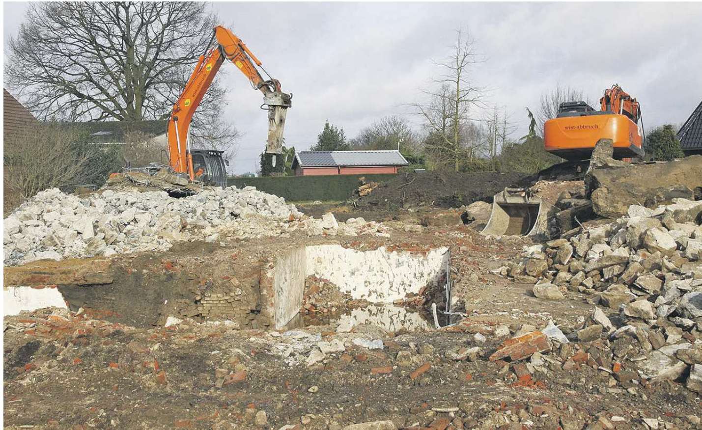
Haben ganze Arbeit geleistet: Die Abrissbagger in der Ortsmitte Foto: tp
