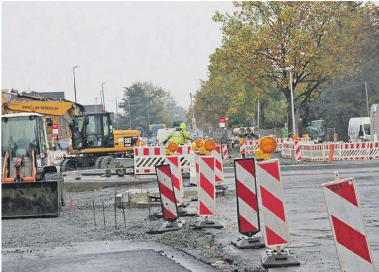
Die Straßen- und Kanalbaustelle im Ortszentrum mit neuem Kreisel Foto: tp
