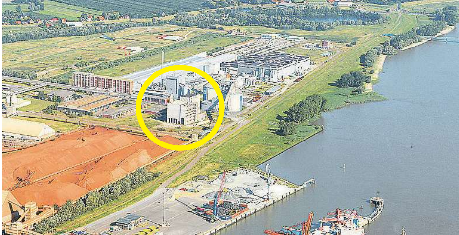
Der Rohbau der geplanten Müllverbrennungsanlage steht schon (Kreis) Foto: www.luftbild.fotograf.de
