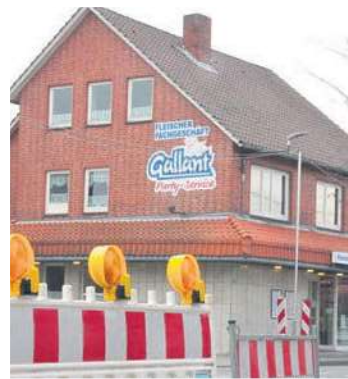
Straßenbaustelle vor der Fleischerei Gallant
