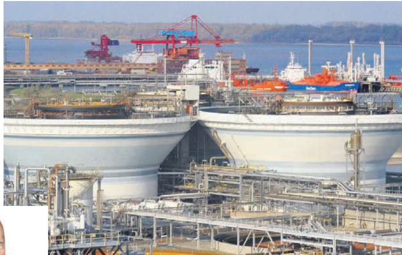
Die riesigen Klärtürme des Dow-Werks
