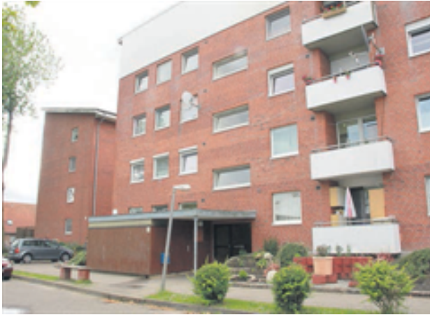
Der „Treffpunkt“ hat seine Räume in dem Wohnblock am Mühlenweg 38
