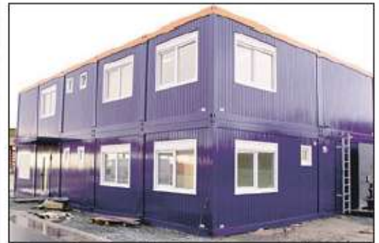
„Containerburg“ mit Büros und Sozialräumen
