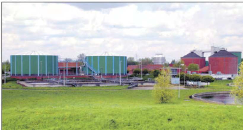
Die AZV-Abwässer werden bislang in der Stader Kläranlage aufbereitet: Die geplante Fusion soll für einheitliche Gebühren im gesamten Stadtgebiet sorgen - eine Lösung für Assel steht noch aus Foto: hr
