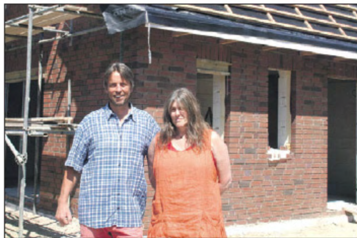
Der Umzug von Tür zu Tür ist für Anfang November geplant: Ralf und Anke Lüdecke vor dem im Rohbau fertigen neuen Hausmeister-Wohnhaus der Bützflether Schule Foto: hr
